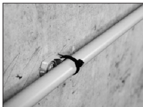
Крепление гибких или жестких кабелей кабельной затяжкой
